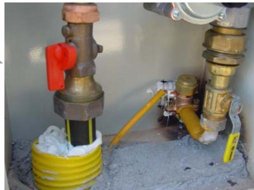
11 - A extremidade superior do espaço anelar entre a tubagem e a manga ou bainha deve ser obturada com um material inerte.
