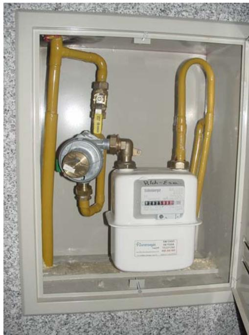
2 - O dispositivo de corte pode ser substituído por um redutor de segurança que exista junto de cada contador, se esse redutor estiver situado no mesmo piso ou no
