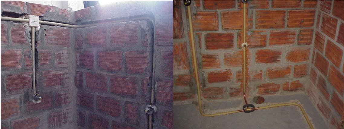
d) No caso das tubagens embebidas nos pavimentos, o percurso deve fazer-se preferencialmente em direcção paralela, com um afastamento máximo de 0,2 m, ou perpendicular à parede contígua.
