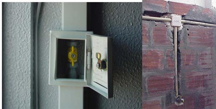
«Caleira» - espaço, confinado mas com acessibilidade de grau 3, contendo uma ou mais condutas, podendo ainda conter alguns acessórios e equipamentos, destinada a garantir a protecção mecânica e a drenagem de eventuais fugas de gás;
