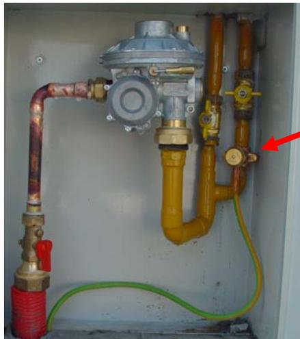
«Junta mecânica» - sistema de acoplamento de dois componentes de uma instalação no qual a união é conseguida por rosca sem estanquidade nos filetes e a estanquidade do circuito de gás por compressão mecânica, com ou sem auxílio de outros meios complementares de vedação;
