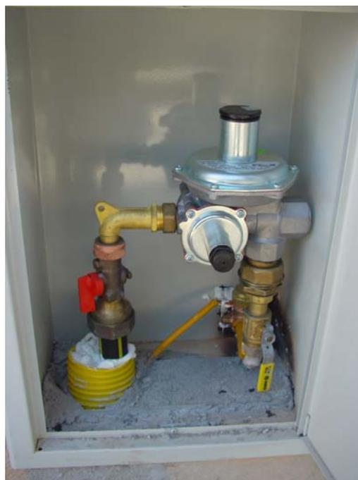
3 - Nas instalações de gás de cidade existentes à data de entrada em vigor do presente Regulamento, e alimentadas em baixa pressão, o dispositivo de corte geral pode ser a válvula de ramal.
