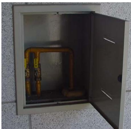
«Dispositivo de corte de um quarto de volta» - acessório da instalação que permite interromper o fluxo de gás com um quarto de volta do manípulo;
