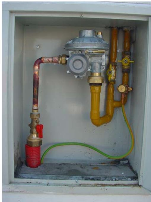
(Instalação de gás com duas colunas montantes)
