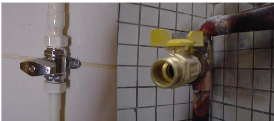
«Dispositivo de corte rápido com encravamento» - acessório da instalação que permite interromper o fluxo de gás, só podendo ser rearmado pela concessionária ou pela entidade exploradora;
