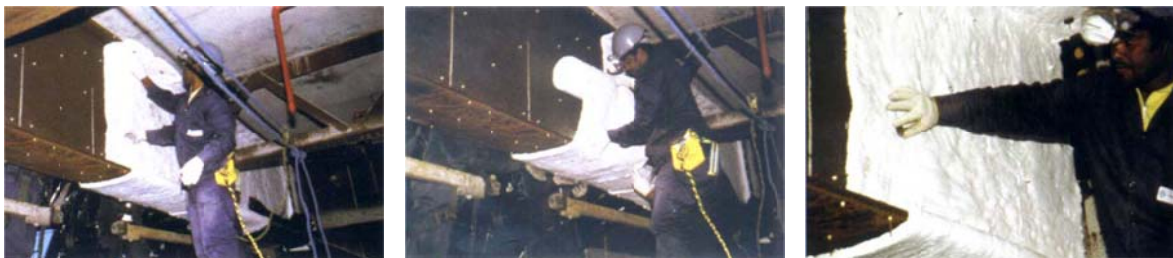
Figura 3.20 – Vista geral e detalhes da fixação da manta em fibra cerâmica num perfil soldado, por meio de pinos.
