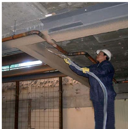
Figura 3.18 – Placa de vermiculite e aplicação em spray como protecção de uma estrutura.
