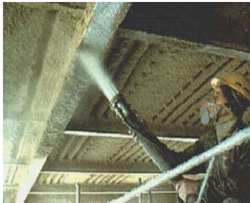
Figura 3.17 Perfil protegido com fibra mineral projectada.
